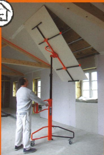
Pose sous rampants d'une plaque de 1,20 x 2,50 m.
